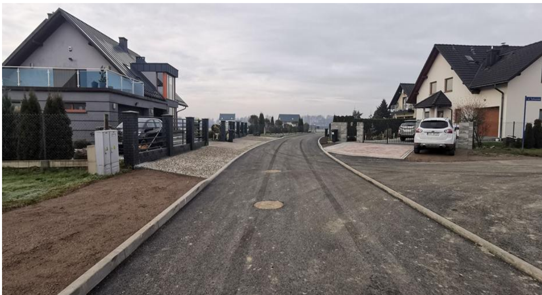
ul. Biała wewnętrzna – po remoncie
